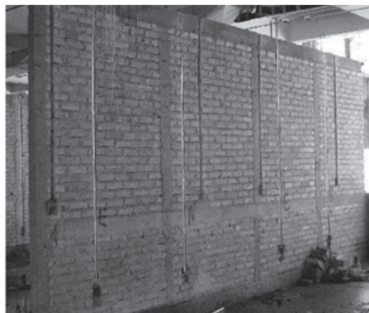
Ranurado de muro y colocación de tuberías y cajas.
