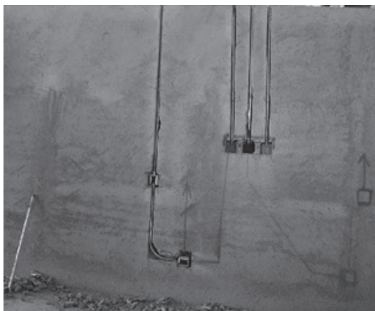
Ranurado de muro y colocación de tuberías y cajas.
